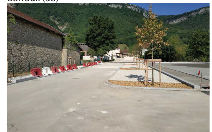
Stationnement VL en Concassé 40/60 - Ref Paladru (38)
