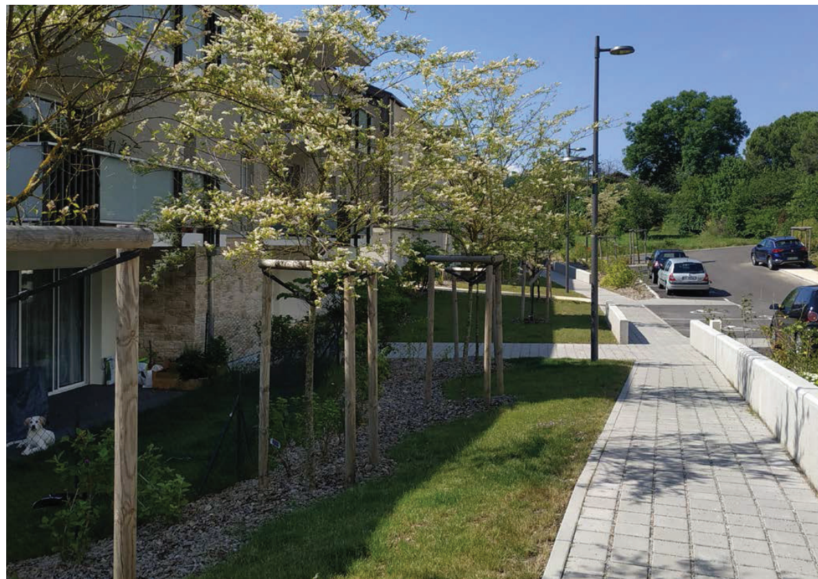
Cheminement en pavés béton drainant - Ref Les Lodges- Bernin (38)
