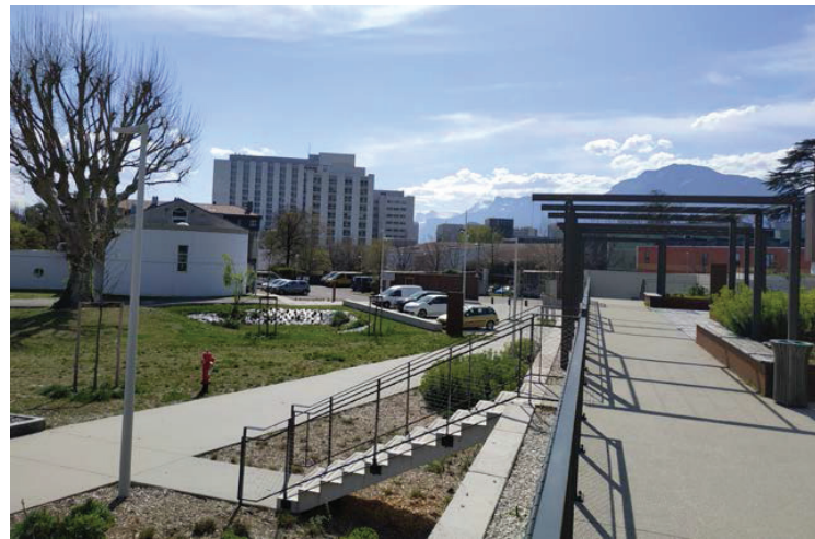
Cheminement en pavés béton drainant - Ref Les Lodges- Bernin (38)
