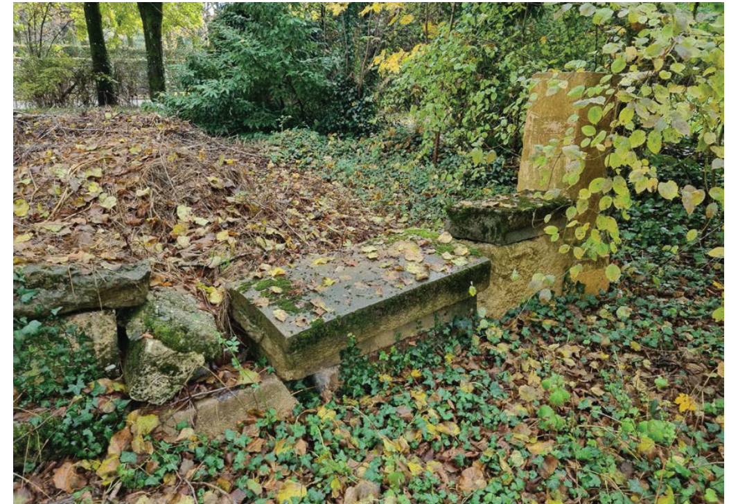
Pierres de taille disparates entreposées
