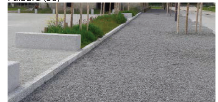
Stationnement VL en Concassé 40/60 - Ref Paladru (38)
