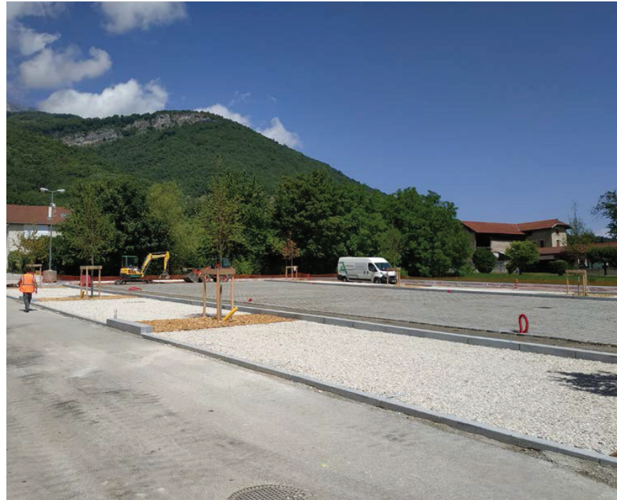
Stationnement VL en Concassé 40/60 - Ref Barraux (38)
