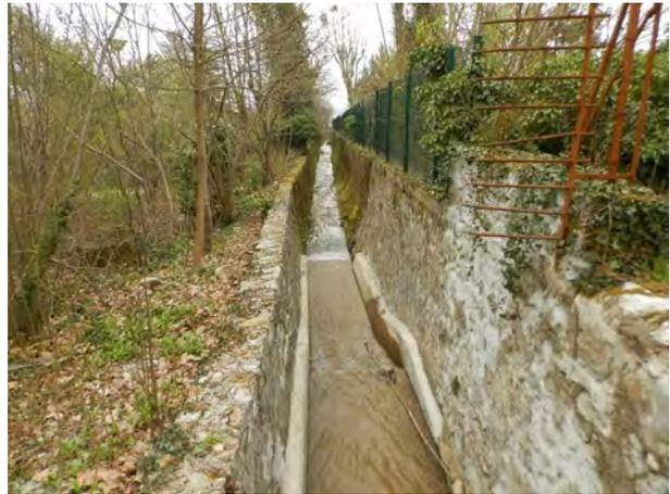
Sur ce tronçon dit « du Carmel », le torrent coule entre des digues, au-dessus du terrain naturel. Ces digues en maçonnerie de pierres sèches présentent en général une butée en terre (cf. figure suivante). De grands arbres se sont développés en tête de ces remblais et pourraient occasionner des dégâts importants aux protections en cas de renversement (tempête). La digue rive gauche apparaît généralement plus basse et plus fragile qu'en rive droite.
