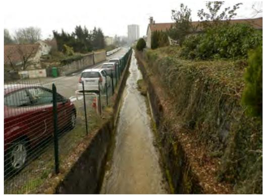
L'entonnement du Charmeyran dans la canalisation  $\Phi 1200$  est bien réalisé et en bon état. L'amont de l'entonnement représente une ouverture de 0,85 m de haut par 1,8 m de large sur laquelle repose une vanne. Une rampe bétonnée avec des berges profilées permet ensuite de rejoindre la buse  $\Phi 1200$ .
